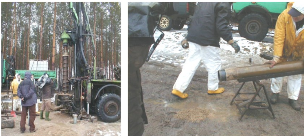
Abb. 4-6: Bohrung eines Multilevelpegels (MLP2) mit Entnahme von Bohrkernen
